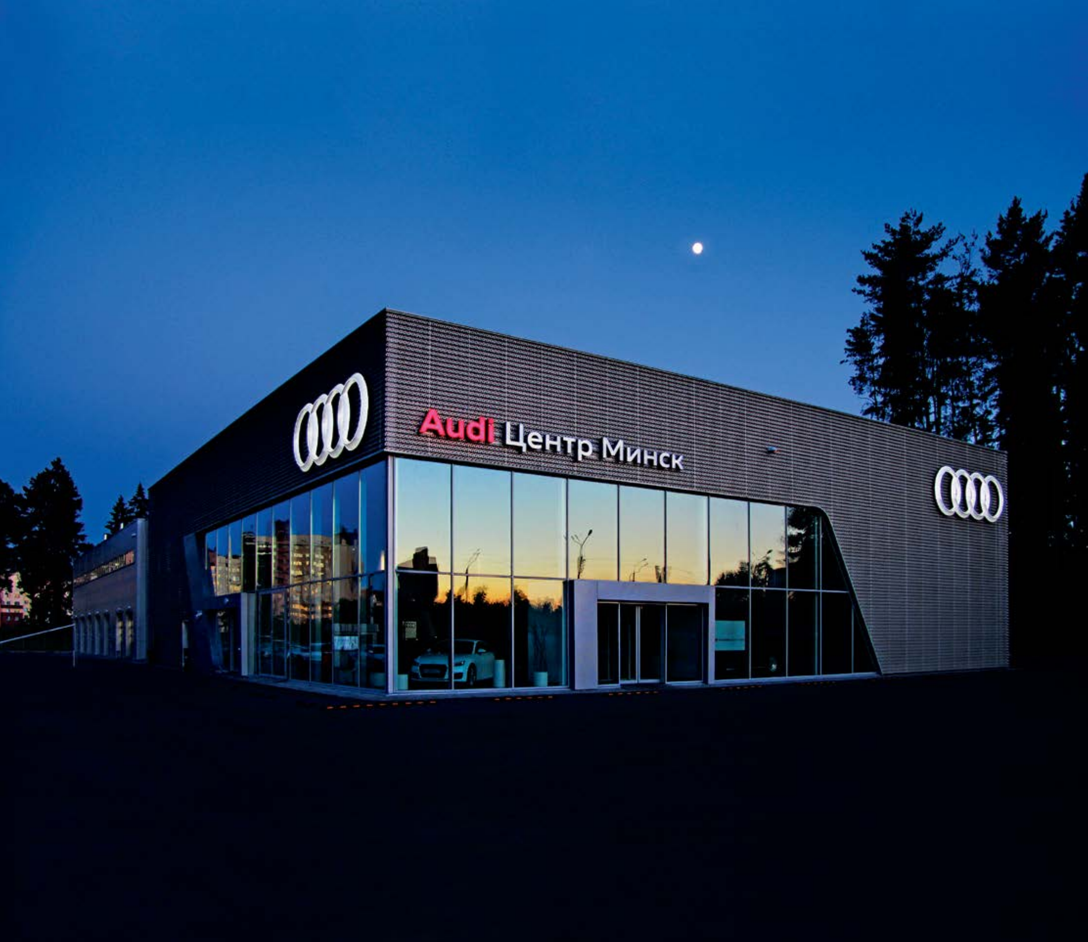
Audi Центр, Минск Главный архитектор Чучвага С. В., ИЧАПУП «Формат БСТ»
