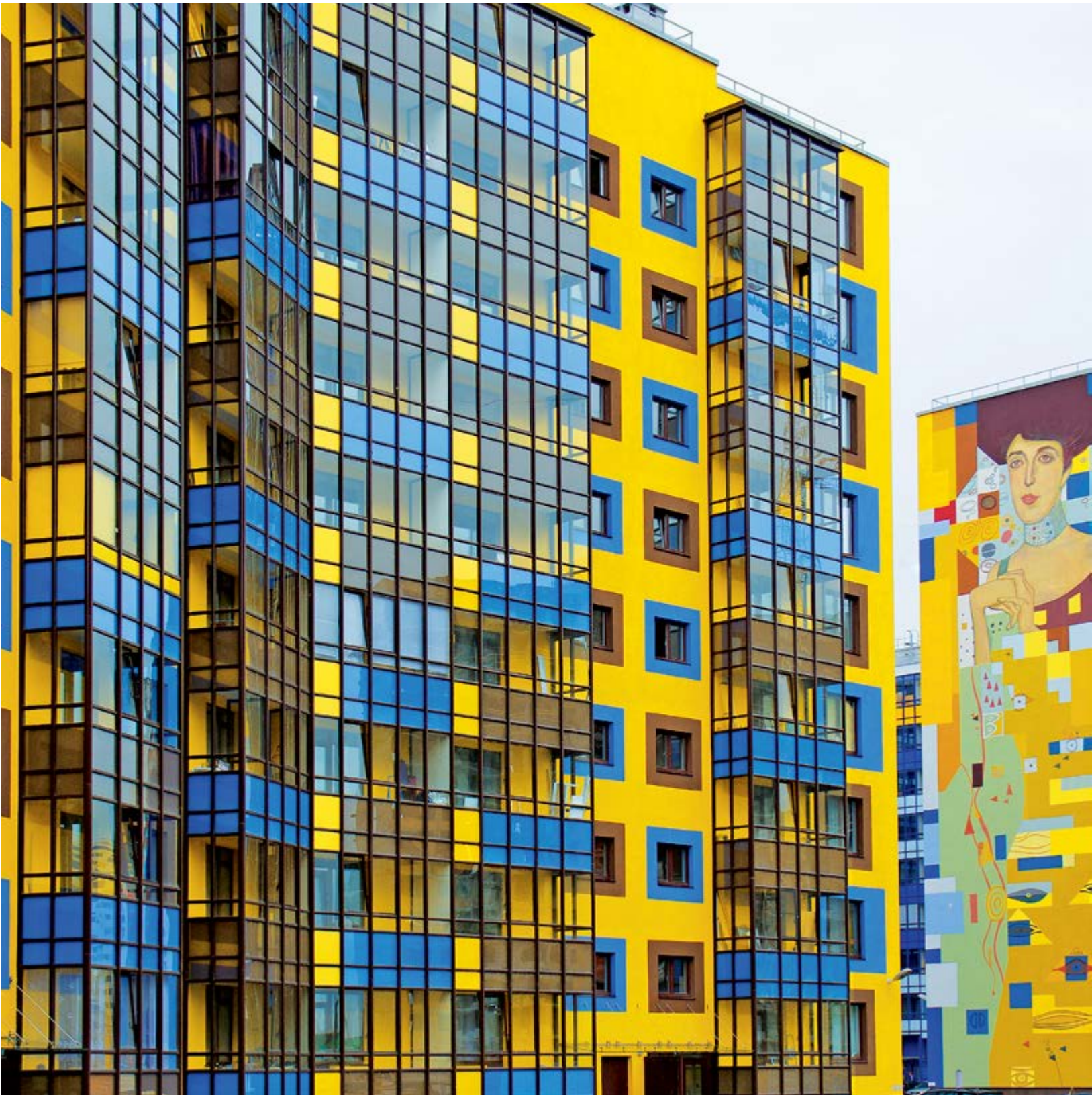
Жилой комплекс «Семь столиц», квартал «Вена», Всеволожский район, Ленинградская область
